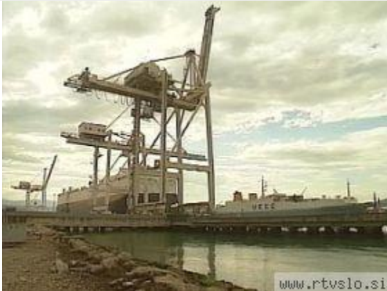
V Luki Koper zaradi vetra prihaja do zastojev pri delu z dvigali. Ta so namreč opremljena z varnostnimi sistemi, ki dvigala ob določenih jakostih vetra samodejno izključijo. Foto: MMC RTV SLO
